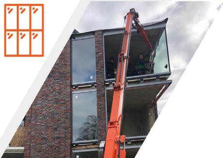
Instalación de acristalamientos y muros cortina en edificios y rascacielos, manipulación de placas de cristal y materiales no porosos usando los manipuladores hidráulicos y los elevadores con ventosas integrados en nuestras grúas.
