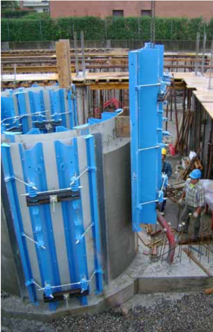
Cantiere edilizia privata, Como, Italia Chantier de travaux privés, Côme, Italie Obra edilicia privada, Como, Italia
